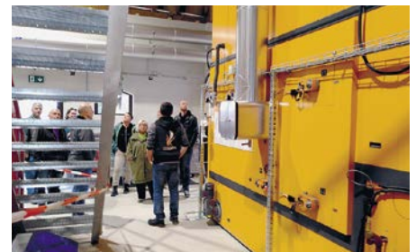
Das Innenleben des ehemaligen Stalls wurde zur modernen Schnitzelheizung umfunktioniert.
