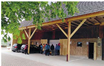
Das ehemalige Ökonomiegebäude konnte mit Auflagen des Heimatschutzes zu einer Heizzentrale umgebaut werden.
